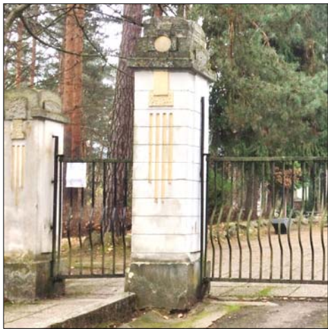
levý vratový pilíř
