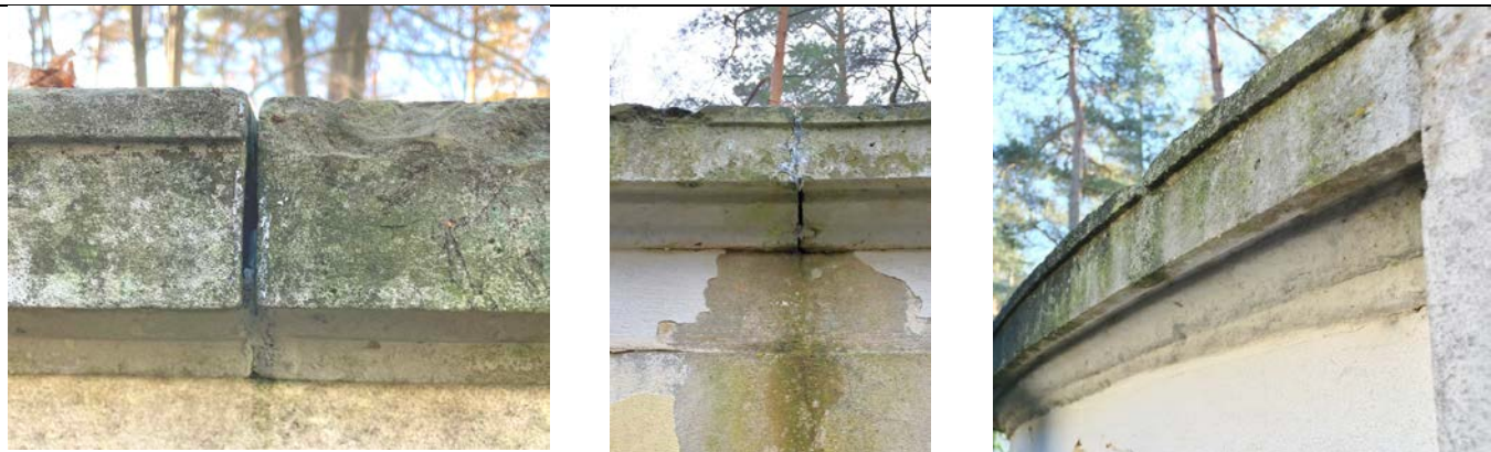
Foto poškozeného povrchu hlavic sloupů
