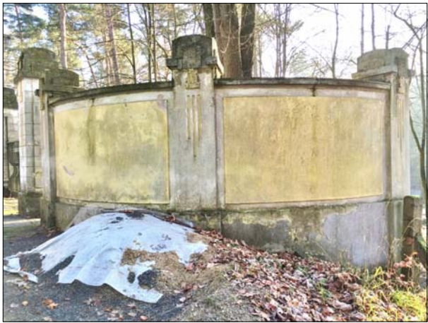
levé obloukové křídlo
