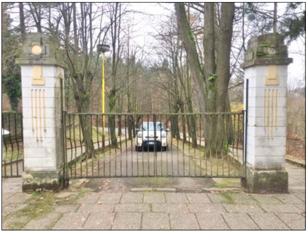
"vnitřní" pohled na bránu
