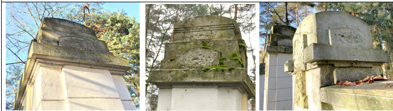
Foto poškozeného povrchu hlavic sloupů
