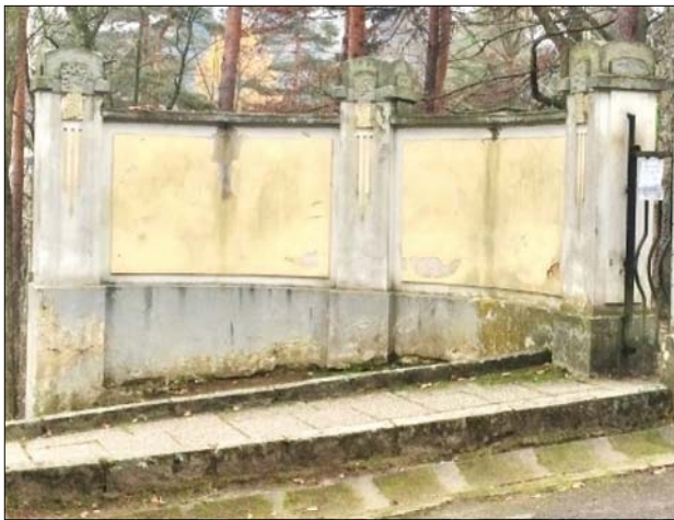
levé obloukové křídlo
