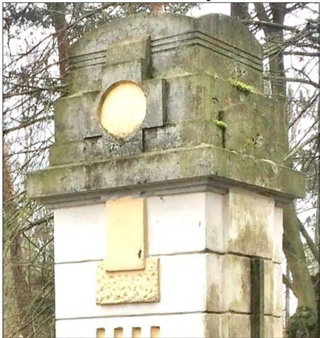
stávající stav pravého vratového pilíře
