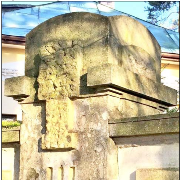
stávající stav středního pilíře pravého křídla
