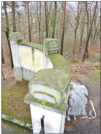
levé obloukové křídlo
