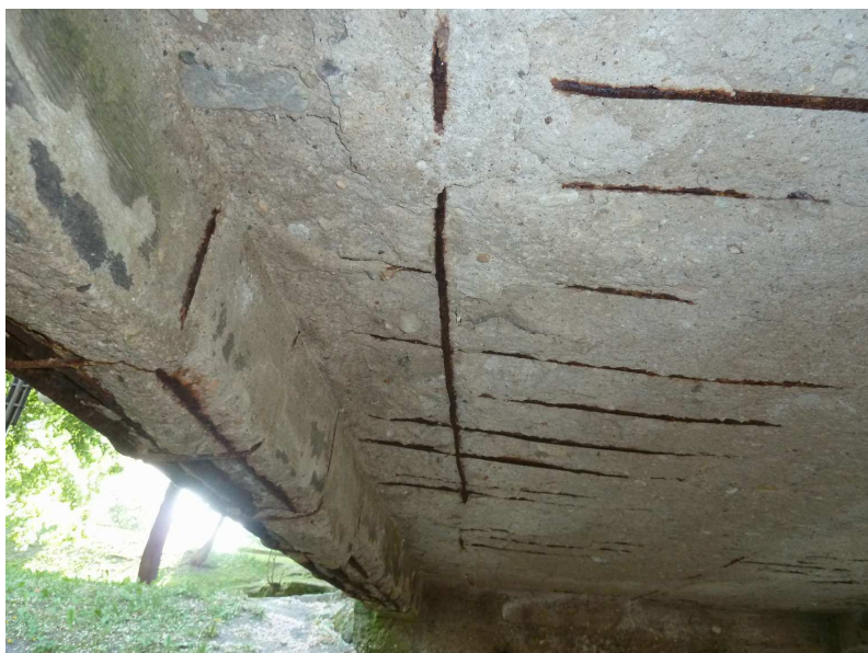
Nedostatečné krytí výztuže, degradace betonu, obnažená korodující výztuž
