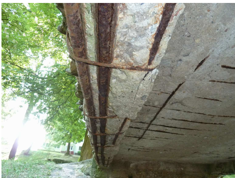
Detail degradace betonu ŽB trámu na vtoku, odpadlý beton, obnažená korodující výztuž
