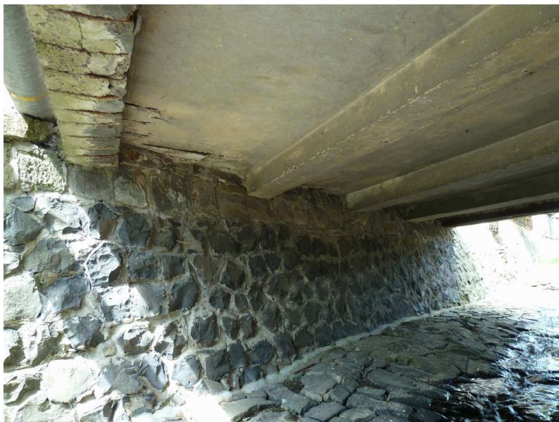
Podhled nosné konstrukce a pravá opěra
