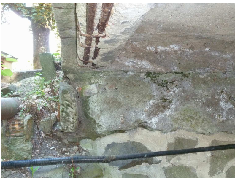
Detail degradace betonu ŽB trámu na výtoku vpravo, odpadlý beton, obnažená korodující výztuž, degradace betonu opěr
