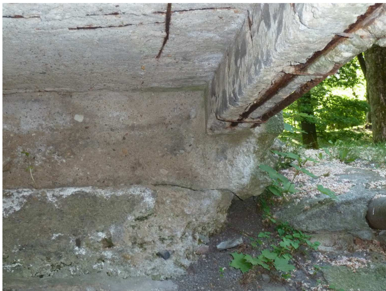
Detail degradace betonu ŽB trámu na výtoku vlevo, odpadlý beton, obnažená korodující výztuž, degradace betonu opěr
