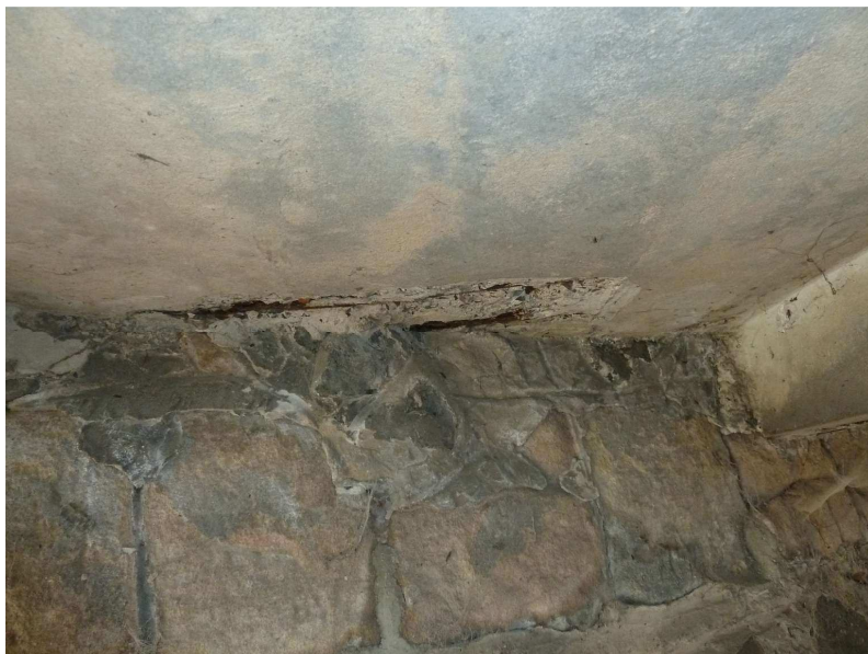
Detail NK před uložením, odprýsknutý beton, obnažená korodující výztuž
