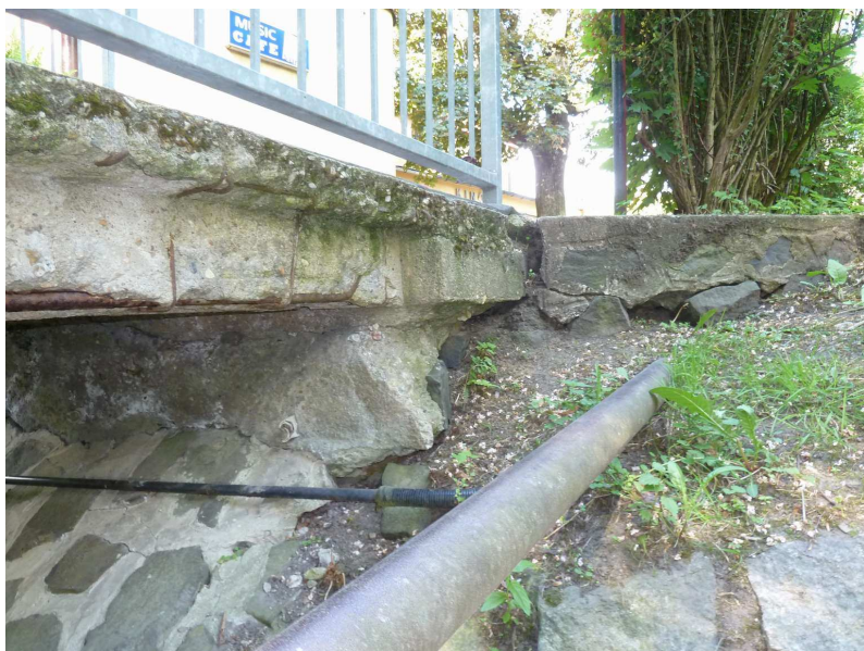
Detail degradace betonu ŽB na vtoku vpravo
