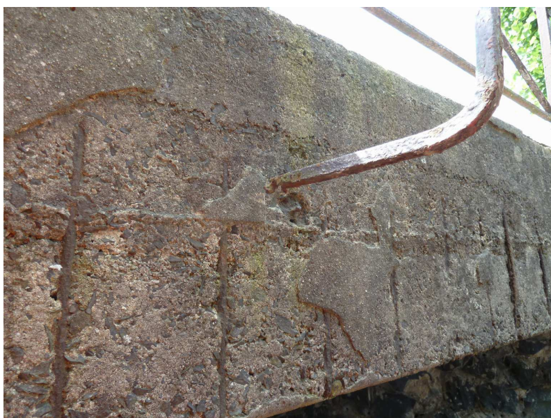
Detail římsy na vtoku, oslabení korozí zábradlí ve vetknutí do římsy
